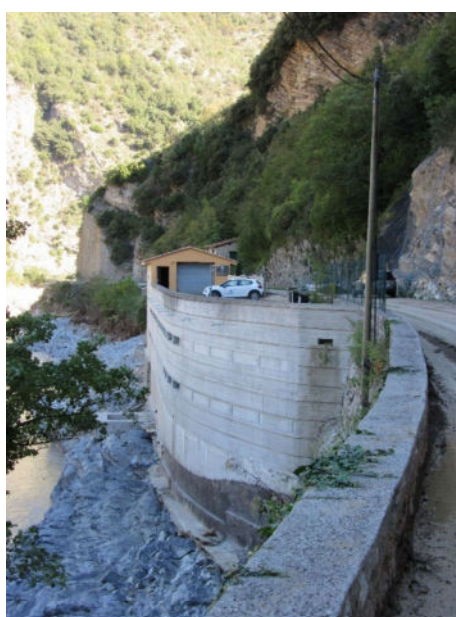
Photo de la station d'épuration de Breil-sur-Roya
