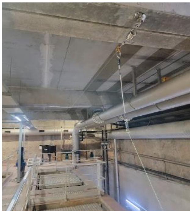
STEP de Menton : Sécurisation par ligne de vie
