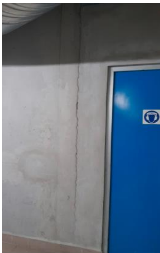
Détail Fissures niveau -1 et en plafond niveau -3
