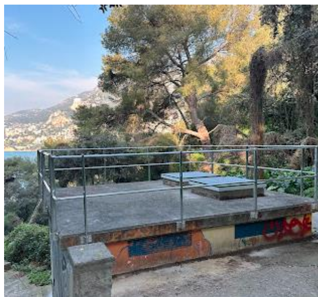
PR DRAGONNIERE : Sécurisation anti chute
