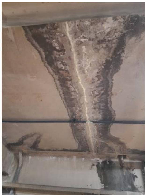
Détail Fissures niveau -1 et en plafond niveau -3
