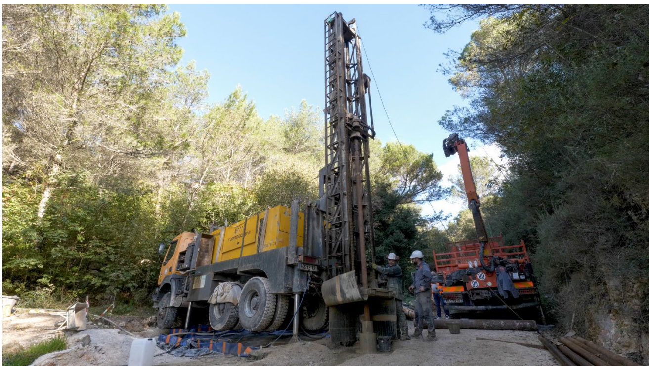
Forage réalisé sur la commune de La Turbie
