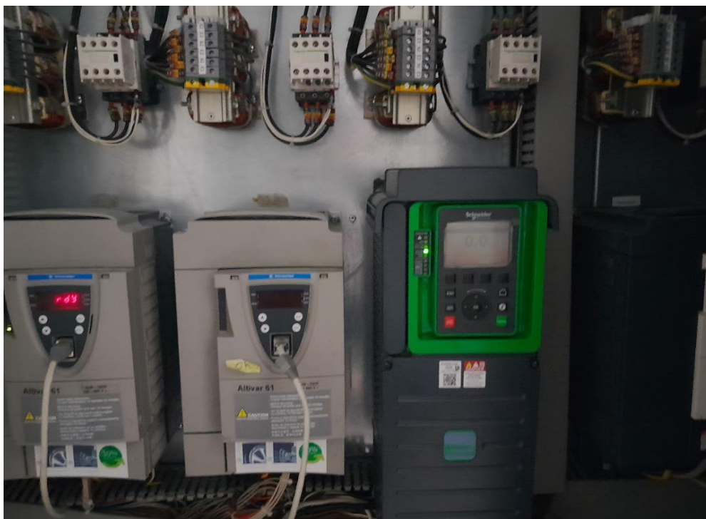
Variateur de fréquence Pompe 3 F2
