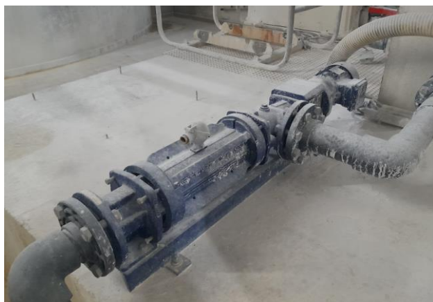
POMPE CIRCULATION LAIT DE CHAUX (seepex) SEC
