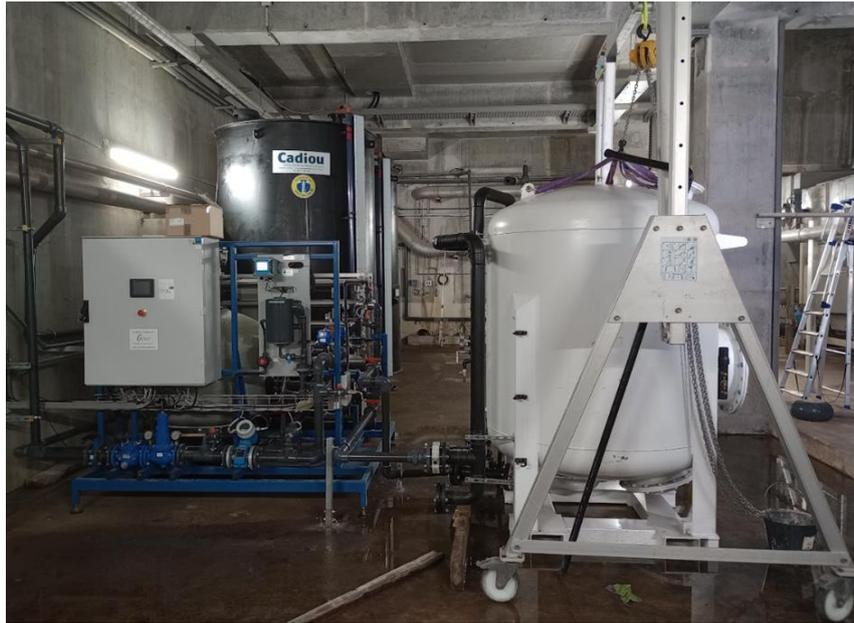
C'est une solution intégralement automatisée avec un minimum d'exploitation, c'est une solution modulaire, standardisée et évolutive qui permet de s'adapter aux besoins des usages internes comme externes. La REUT BOX permet de traiter les eaux usées en sortie de station d'épuration. Elle élimine les matières en suspension ainsi que les virus et bactéries présents dans l'eau et produit une eau de qualité A française, uniquement installée sur des STEP au rejet conforme.
