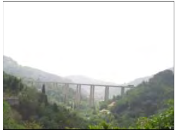
Viaduc de l'A8 franchissant une vallée en amont de Menton
