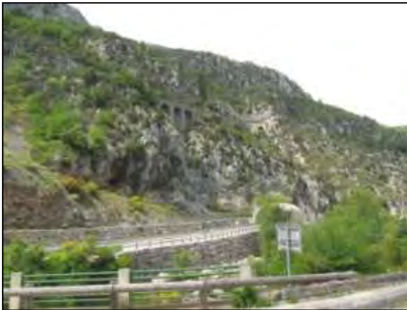
Exemple d'infrastructures dans le Haut-Pays
