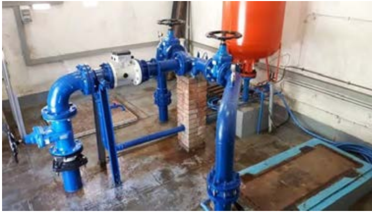
Clapet à Disque concentrique DN80, Clapet à Battant, Vannes Manuelles
