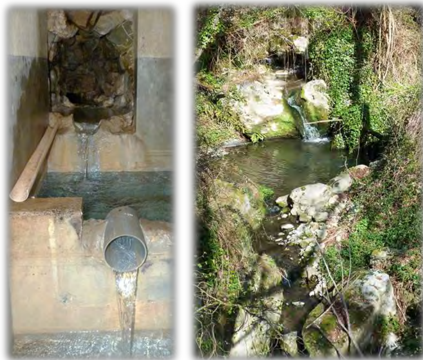
Installation au niveau de la source Goura et ses environs
