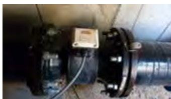
Débitmètre sur canalisation
