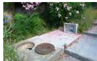
Compteur à l'extérieur du regard
