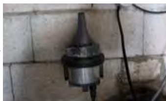
Poste local de sectorisation
