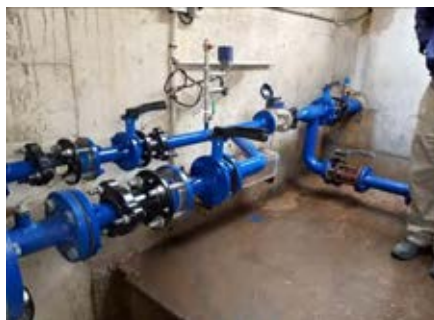
Vannes Manuelles DN100 et DN50
