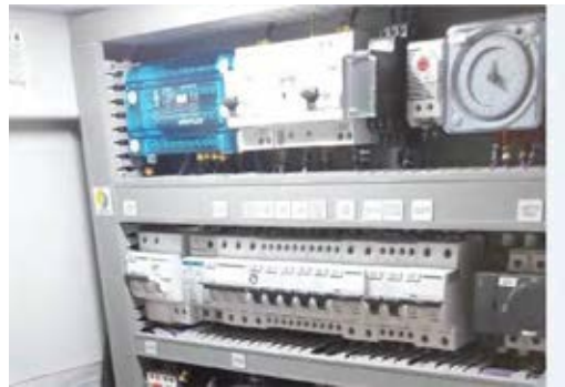
Réenclencheur Automatique
