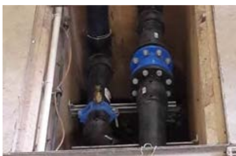
Clapet à Disque Concentrique DN100
