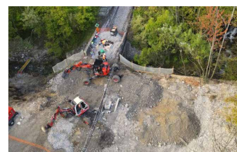
Reconstruction du remblai de Branégo
