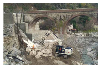
Confortement des berges du viaduc des 3 arches
