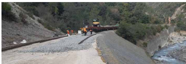
Début des travaux de pose de la voie sur le remblai de Cottalorda par SNCF Réseau
