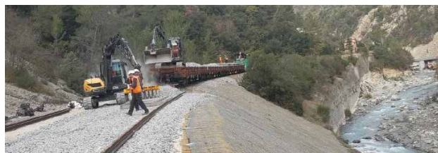
Début des travaux de pose de la voie sur le remblai de Cottalorda par SNCF Réseau
