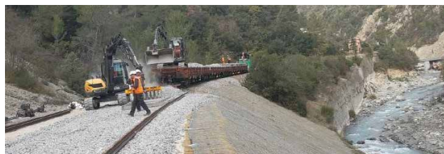
Début des travaux de repose de la voie sur le remblai de Cottalorda par SNCF Réseau
