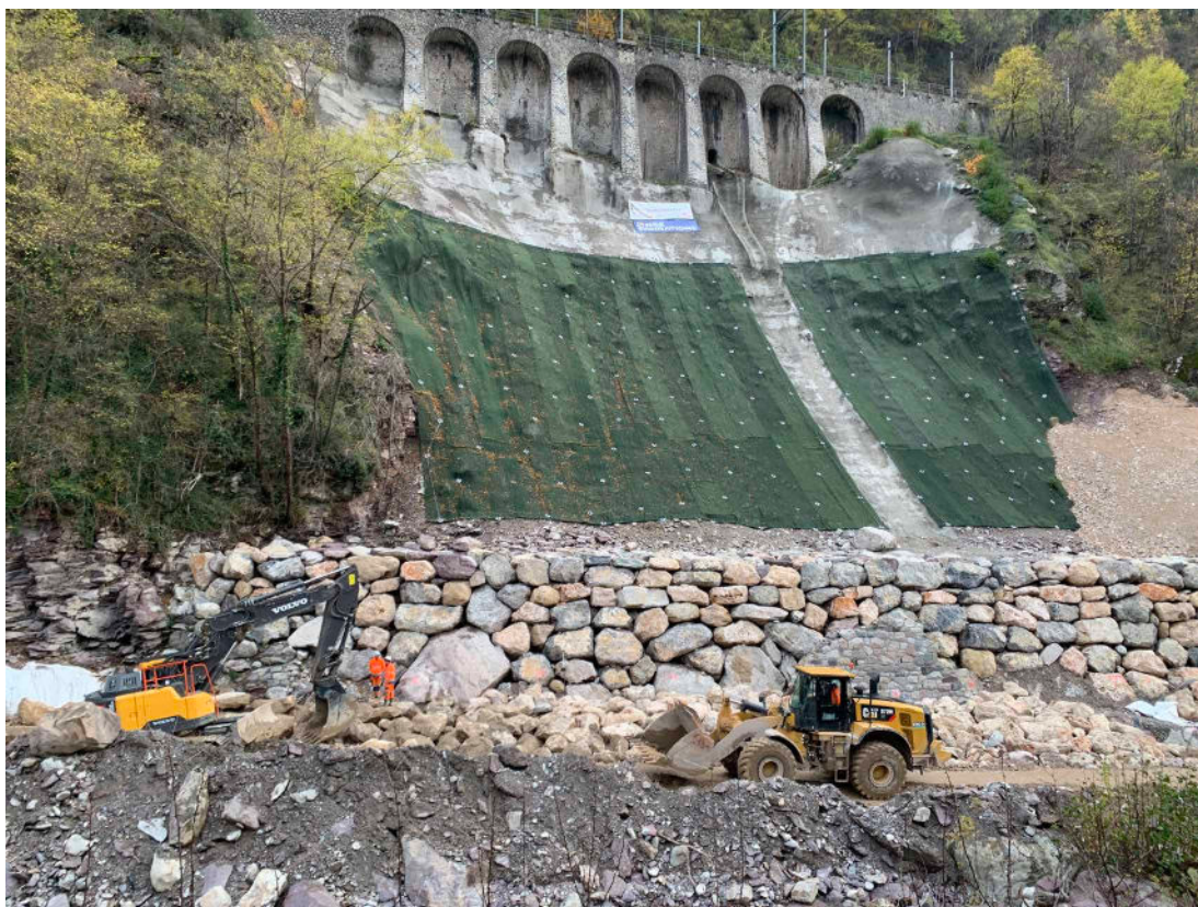
Travaux d'enrochements complémentaires sur la butée au pied du mur à arcatures
