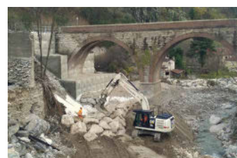
Confortement des berges du viaduc des 3 arches
