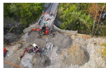
Reconstruction du remblai de Branégo
