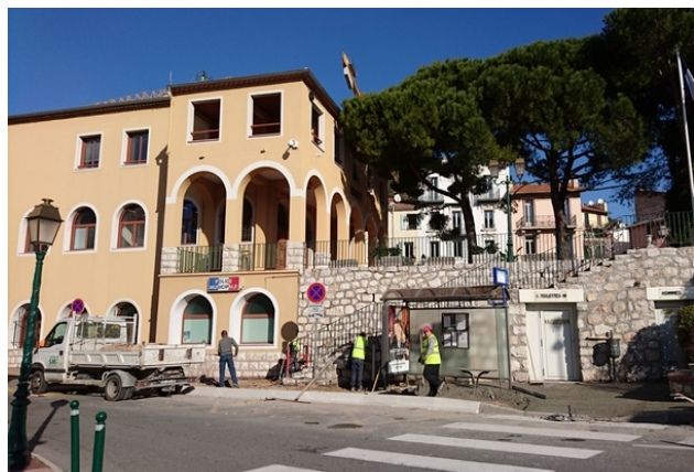
Travaux de mise en accessibilité d'un arrêt à La Turbie
