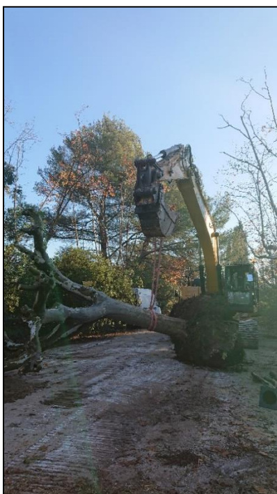
Déterrage et transport d'un platane
