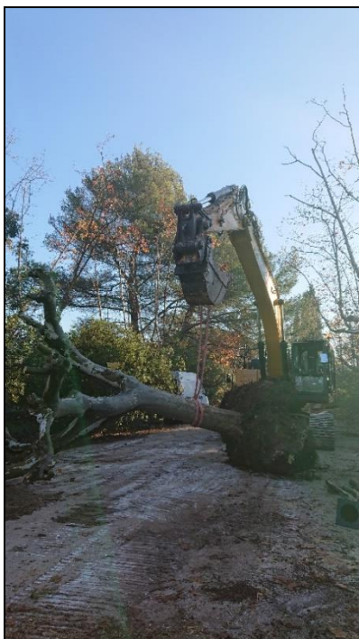
Déterrage et transport d'un platane sur un site varois
