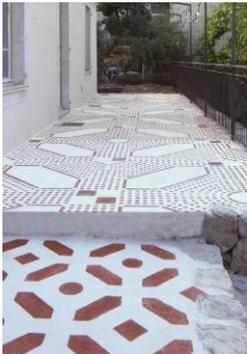
Illustration de réemploi : Utilisation de briques concassées issues de la démolition d'une toiture pour produire un béton décoratif pour l'aménagement de terrasses – Architectes Atelier Aïno – Chantier à La Turbie (06)
